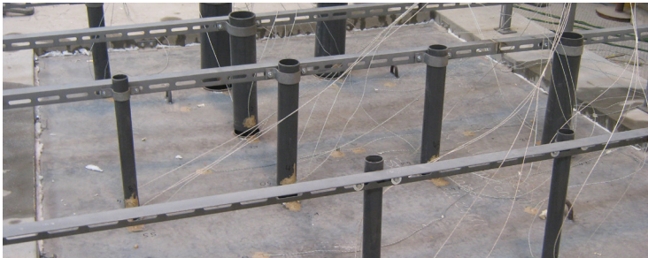
Traversées de tuyauteries dans un pont A-60.
