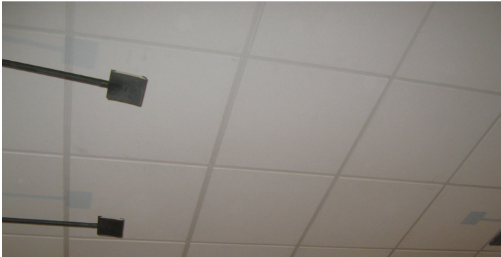
Face exposée d'un plafond avant l'essai
