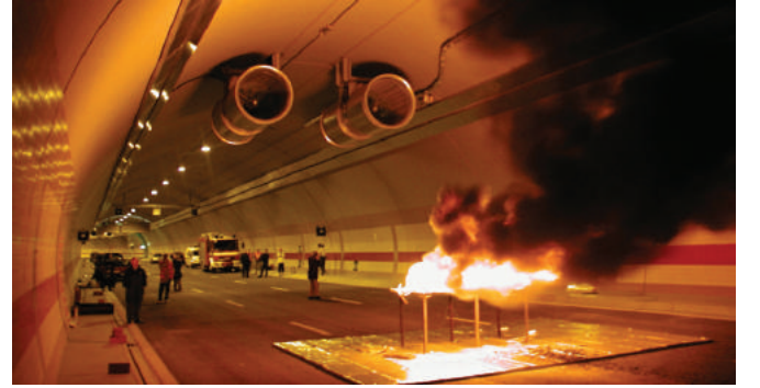
Mevcut tünellerde duman tahliye sistemlerinin yerinde testleri
