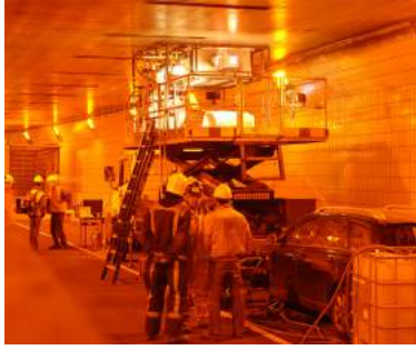
Tünelde Mobil Fırın ile gerçekleştirilen yangına dayanım testi
