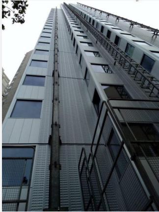
Façade en cours de réhabilitation
