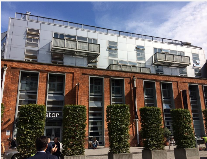
Façade existante d'un bâtiment au Royaume Uni
