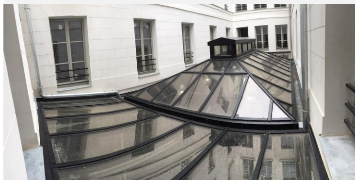
Vue extérieure de la verrière – réalisation BRIAND INDUSTRIES
