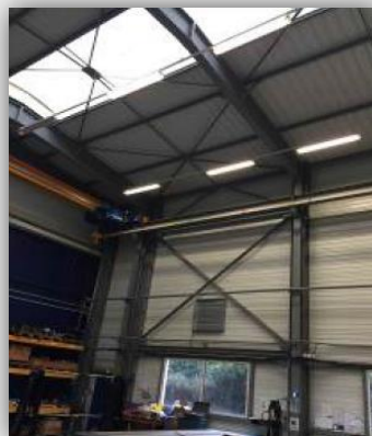
Vérification du désenfumage
