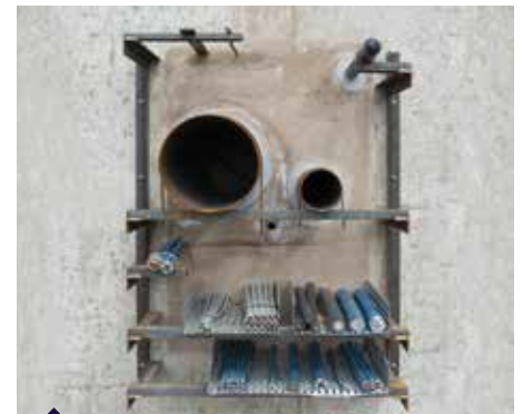
Wasserdichtheitsprüfung von Abschottung
