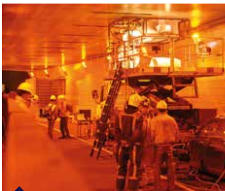
Essai feu en tunnel grâce à notre four MobiFire®
