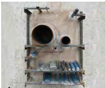
Essai d'étanchéité à l'eau d'une trémie mixte
