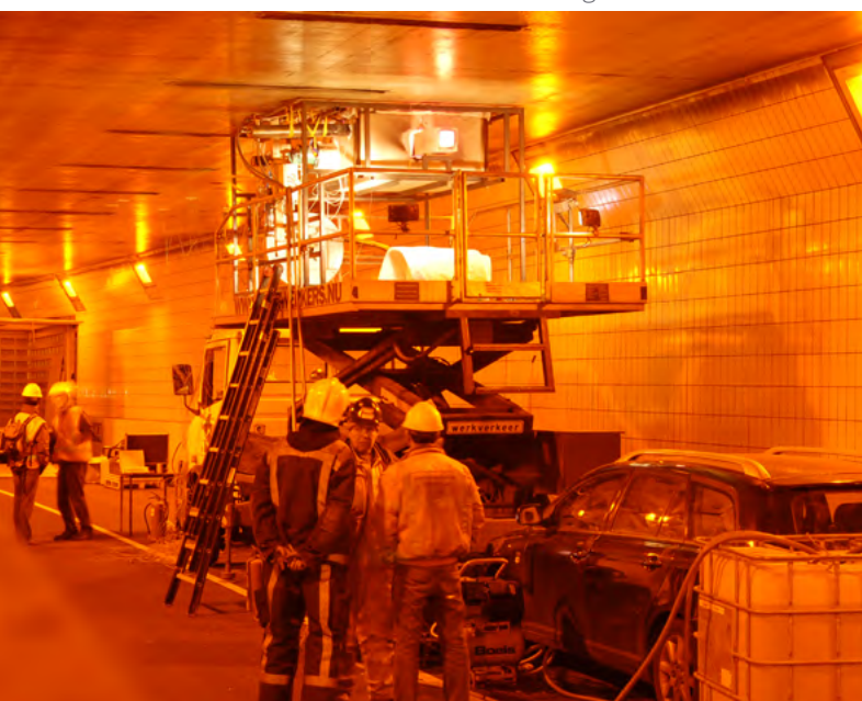
Tests d’écaillage in situ au four mobile
