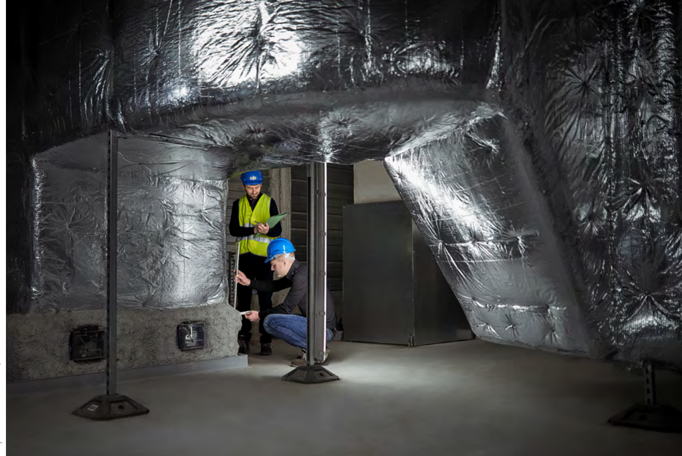
Expertise sur site, conduits
