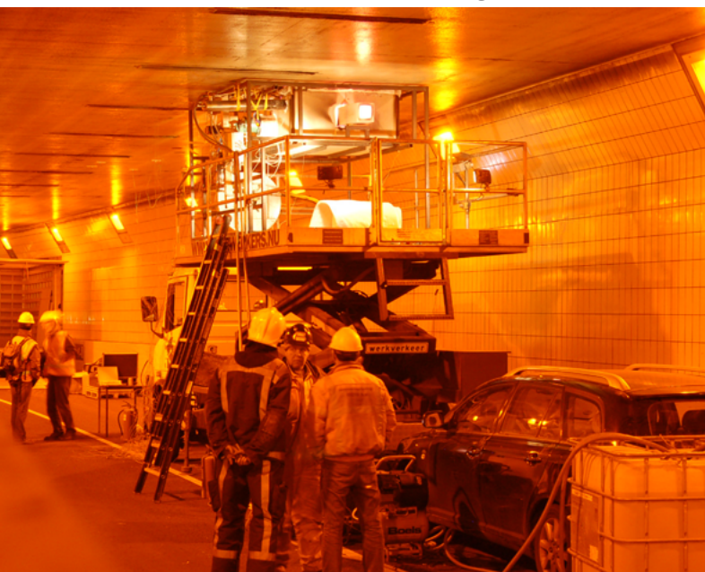
Tests d'écaillage in situ au four mobile
