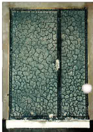
Porte vitrée après essai
