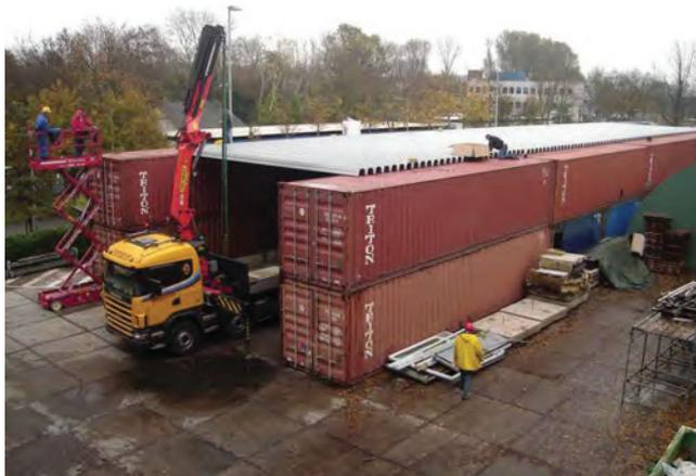
Строительство временного туннеля для проведения ситуативных пожарных испытаний
