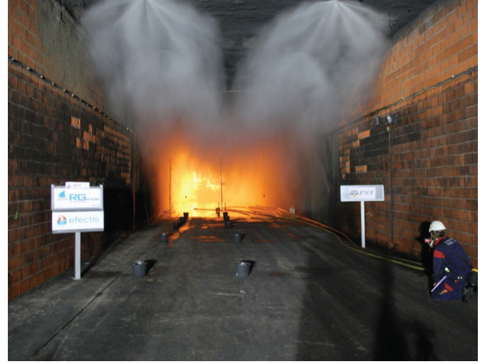
Aktifleştirilmiş su sisi yangın söndürme sistemi
