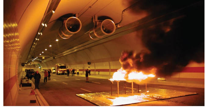
Mevcut tünellerde duman tahliye sistemlerinin yerinde testleri
