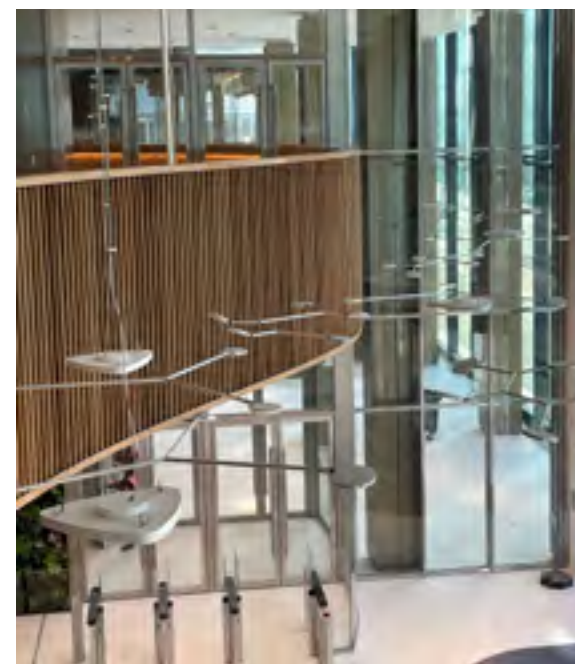
Avis de chantier sur une verrière pare-flamme
