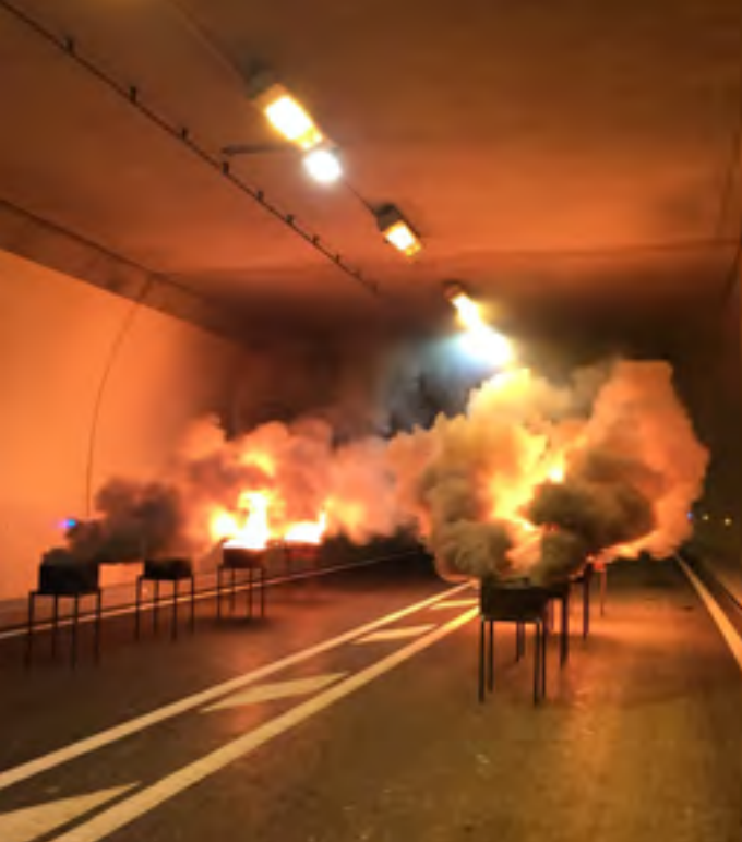
Essais du système de désenfumage, tunnel de Saint Beat
