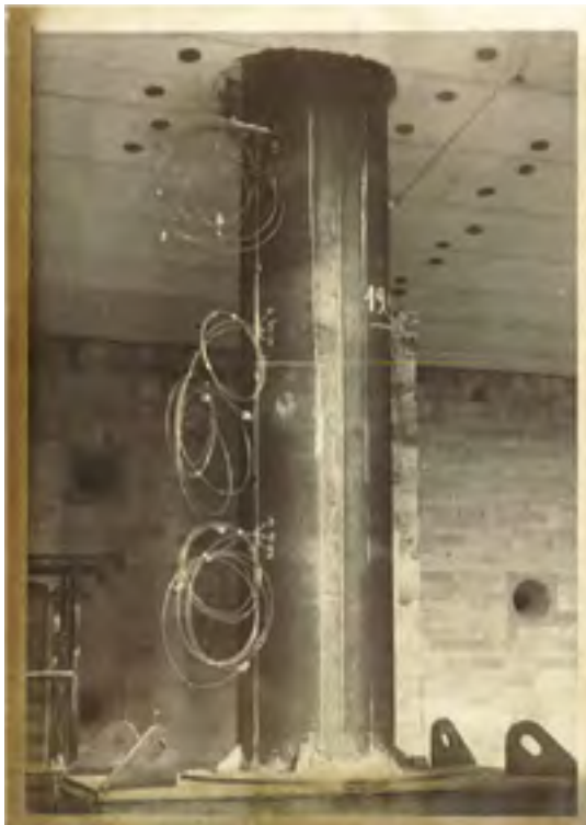
Essai de poteau acier rempli de béton, laboratoire de Maizières-lès-Metz, 1969
