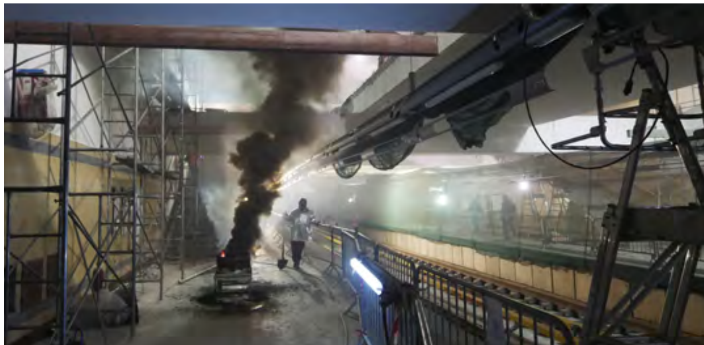
Essai de désenfumage dans une station de métro
